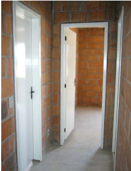
Interior de unidad del Prosamim en construcción
