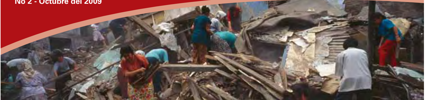
Gente buscando entre los escombros de una casa destruida por un terremoto en Estambul, Turquía © Mark Edwards/Peter Arnold Inc.
