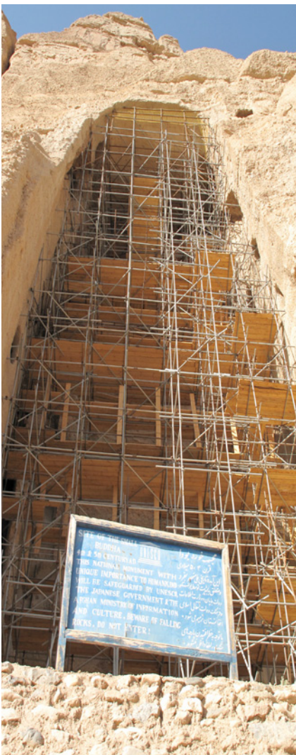
Travaux de consolidation de la niche du Grand Bouddha dans la vallée de Bamiyan (Afghanistan)
