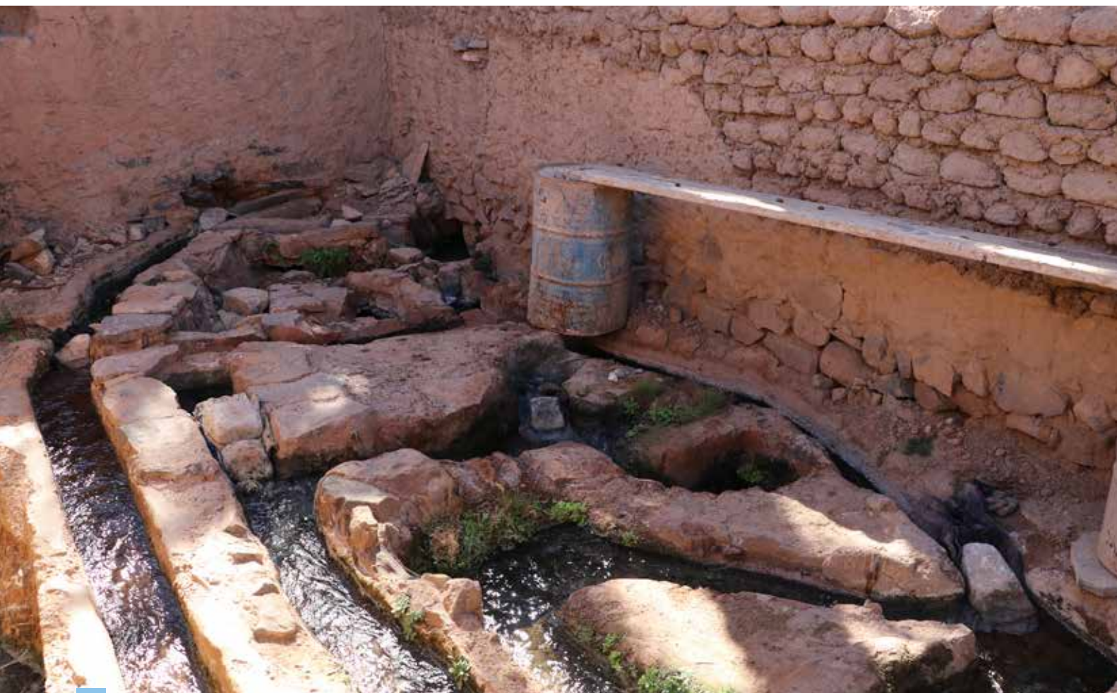
Distribution d'eau provenant des sources locales par des canaux
