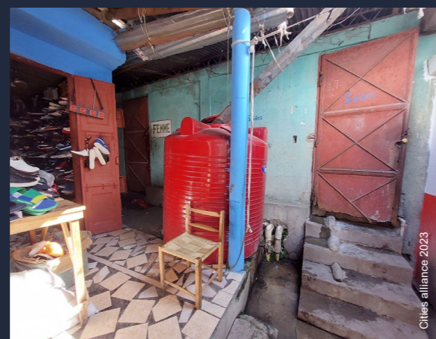
Figure 27 et 28 - Blocs sanitaires du Marché Rival
