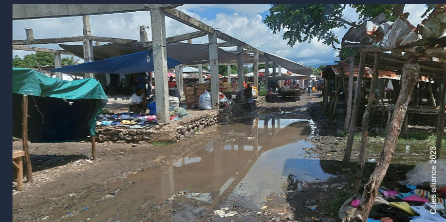
Figure 30 - Inondations du marché après la pluie
